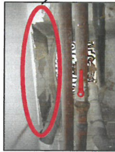
Vestiges de faux plafonds amiantés dans la chaufferie en sous-sol du bâtiment principal
