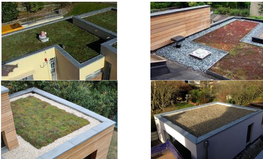
Exemples de toitures stockantes (végétalisées ou non)
