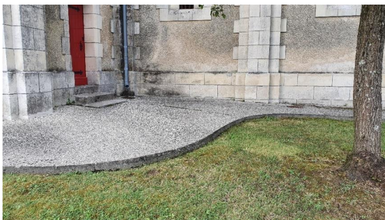
Exemple d'une gestion des eaux de toiture en surface et de manière diffuse dans un espace vert de surface importante (Saint-Palais)
