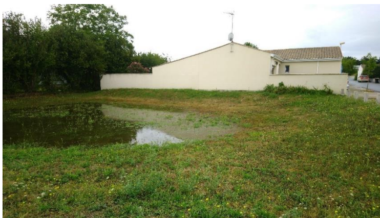
Exemple d'espace vert inondable infiltrant les eaux pluviales de manière diffuse et à faible profondeur (Chaillevette)
