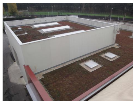
Toiture terrasse stockante
