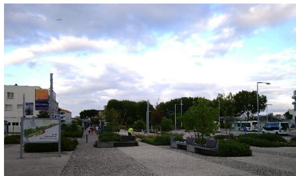
Jardins de pluie inondables sur le parvis de la gare de Royan
