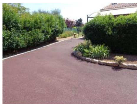
Allée/parking en enrobé poreux (source : Celtivia)
